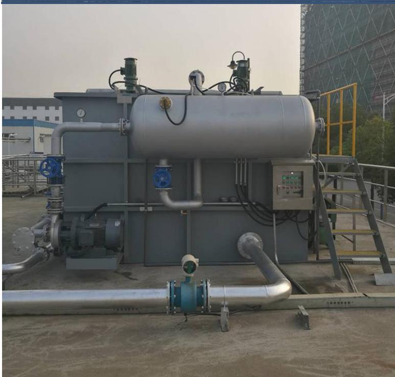
将化学反应与气浮结合于一体的装置。
